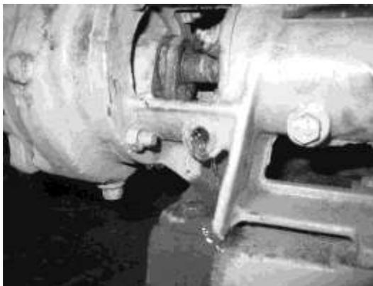
Рис. 2.20 Утечки воды через сальниковую набивку консольного насоса
