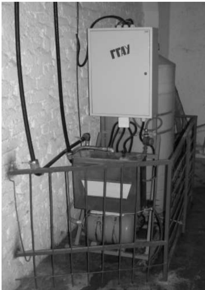
Рис. 7.3 Электротехнологическая установка для обработки воды
