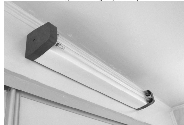
Рисунок 23 – Использование бактерицидных ламп для санации помещений.
